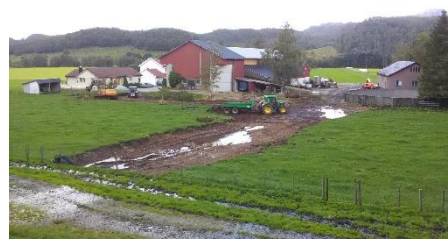
Utgravning av grunnen for det nye storfjøset til Gudmund Oremo. Foto: Paul Tengesdal 9. sept. 2020.
