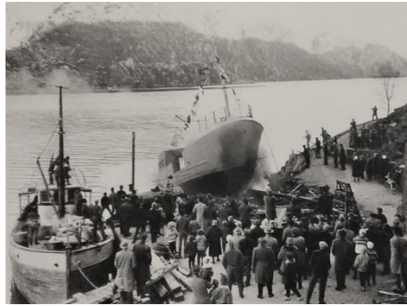
Sjøsetting av Ørsdølen II 8. februar 1964. Foto: Stavanger Aftenblad.
