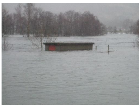
Vannet når like under taket på pumpehuset på Oremo. Her er avsatt et måle-merke. Alle fire foto: Paul Tengesdal.
