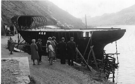
Ørsdølen II under bygging i Odlandstø. Foto: Johan Bjerkreim 1963.
